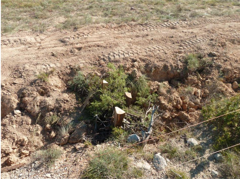
**Figure 22 : Exemple de fascine sèche et comblement de drain en contexte de pelouse**
