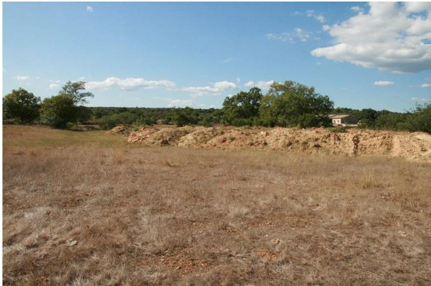
**Figure 25 : Matériaux issus du déblai du bassin de stockage des eaux déposés sur la parcelle attenante**
