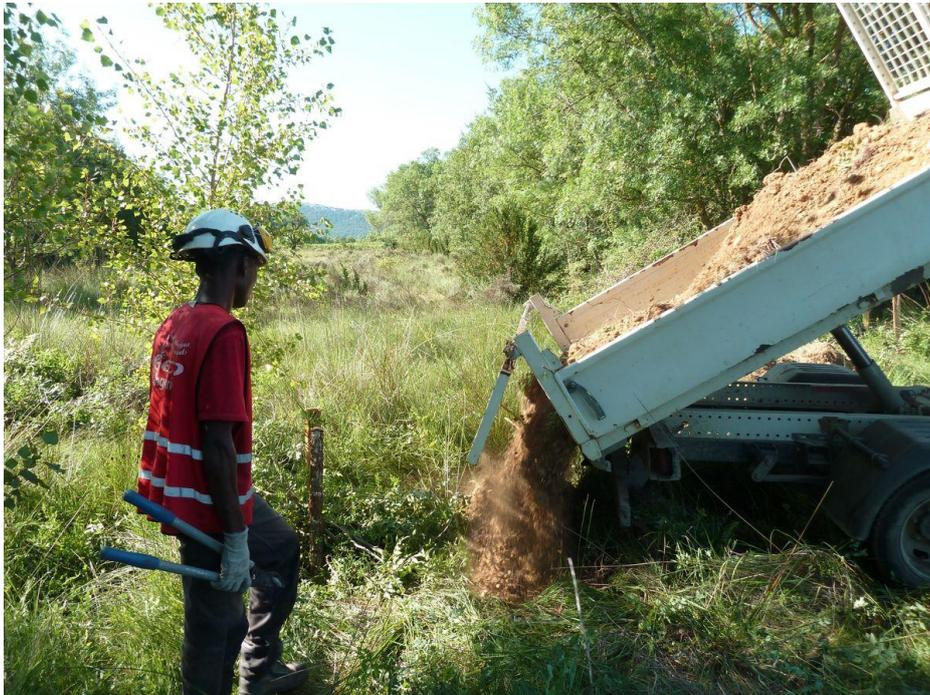
**Figure 23 : Comblement de drain avec des matériaux argileux issus de déblais locaux**
